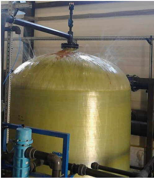
Рис. 3,4 Последствия образования трещины внутренней колбы.
